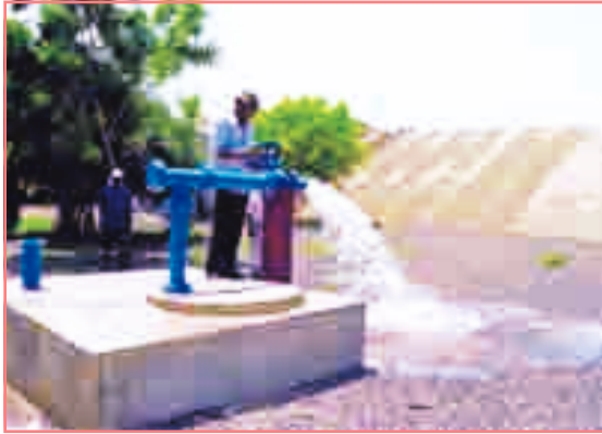
الشكل (١٤) مضخة ارتوازية تسحب الماء من جوف الأرض
