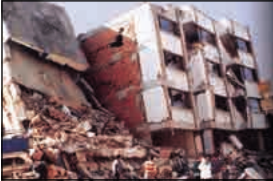
شكل ( ٣ ) أضرار الزلازل
