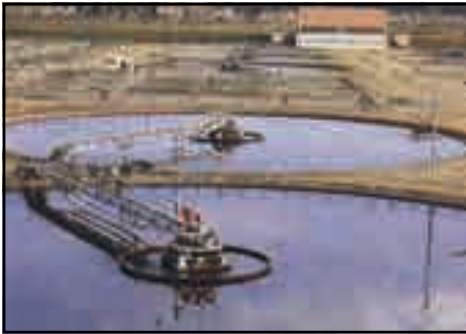
شكل ( ٥ ) محطة معالجة مياه الصرف الصحي
