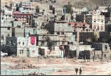
شكل ( ١ ) حي سكني مبني بطريقة عشوائية
