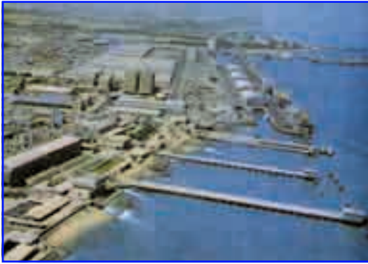
شكل (٦٥) محطة تحلية مياه البحار
