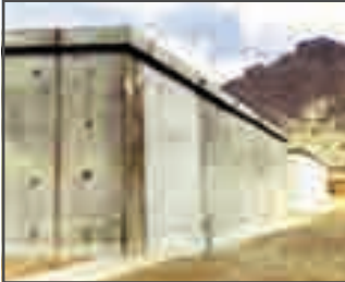
شكل (٣) خزانات مياه
